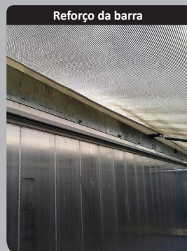
Reforço da barra
