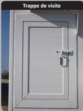
Trappe de visite
